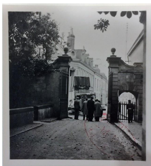
L'arrivée au dépôt de Valençay, septembre 1939, source : Dossier de carrière de Madame Bouchot-Saupique, AN 20150497-196.
