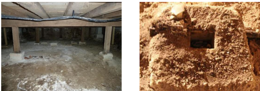
Ill. 14. Pierres taillées recevant les poteaux supportant le plancher et les mâts des décors, sous la scène du théâtre (à gauche) ; détail d'une pierre taillée pour recevoir les mâts (à droite ; cliché A. Geny, op. cit. note 107, p. 83).
