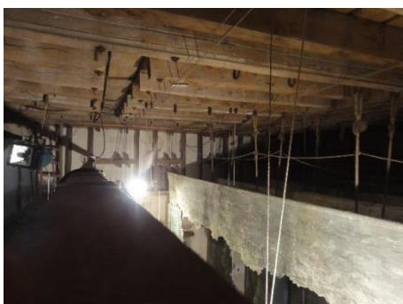
Ill. 6. Les cintres au-dessus de la scène ; l'une de leurs poulies (cliché A. Geny, op. cit. note 107, p. 78).
