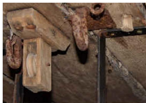
Ill. 6. Les cintres au-dessus de la scène ; l'une de leurs poulies (cliché A. Geny, op. cit. note 107, p. 78).
