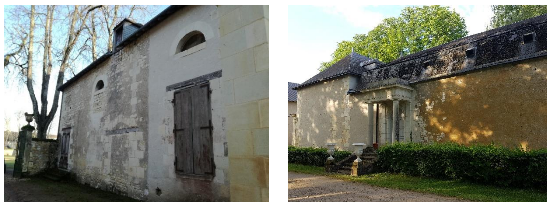
Ill. 2. La façade nord (à gauche) ; la façade ouest sur le parc et l'entrée principale, avec son perron et son portique (à droite).
